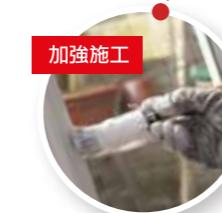
防水施工前可於樓板牆壁的接縫處、裂縫處、落水頭與排水管未連接處，排水管與樓板連接縫，用屋上水切於上述地方塗佈2-3次。
