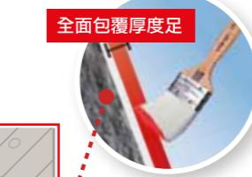
女兒牆內外全包覆施工，並沿著洩水坡施工。防水材料施工厚度必須足夠，防水底漆+屋上水切建議厚度≥2mm。
