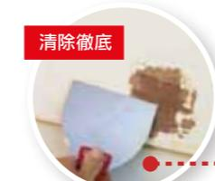
開始動工前，徹底清除鬆動粉化的舊塗層，如舊底材與底層緊密附著則無需刮除。青苔、藻類及石子也要清除乾淨，如此可確保新的防水材料緊密的附著在施工面上。
