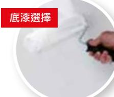
舊防水層為PU、油毛氈、瀝青、磁磚或泡沫水泥等材料，鋪設新的防水材之前可使防水底漆打底。
