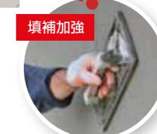
超過2mm以上窟窿或裂縫，請先填補整平。
