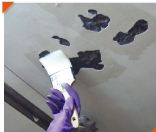
預防/修補室內牆身及天花板滲漏
